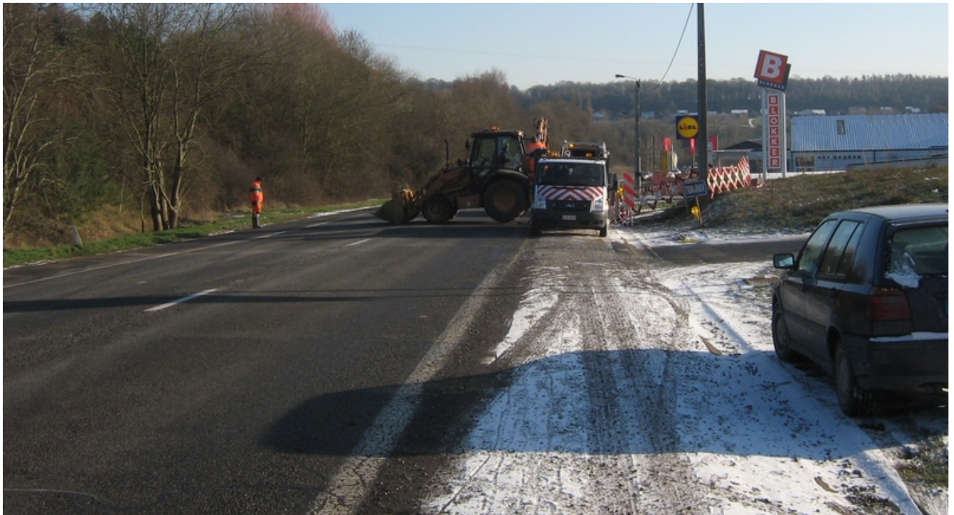
Vue en aval de la rue
